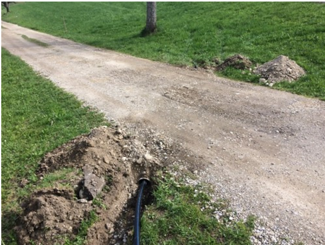
Hausleitungen müssen an die Transportleitung angeschlossen werden.
