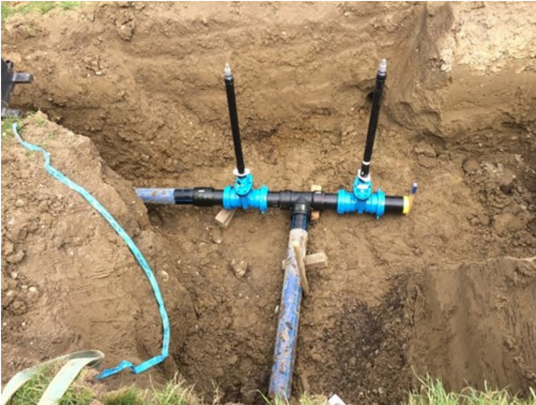
Schieberkreuz mit dem Abgang einer weiteren WAKI-Leitung.
