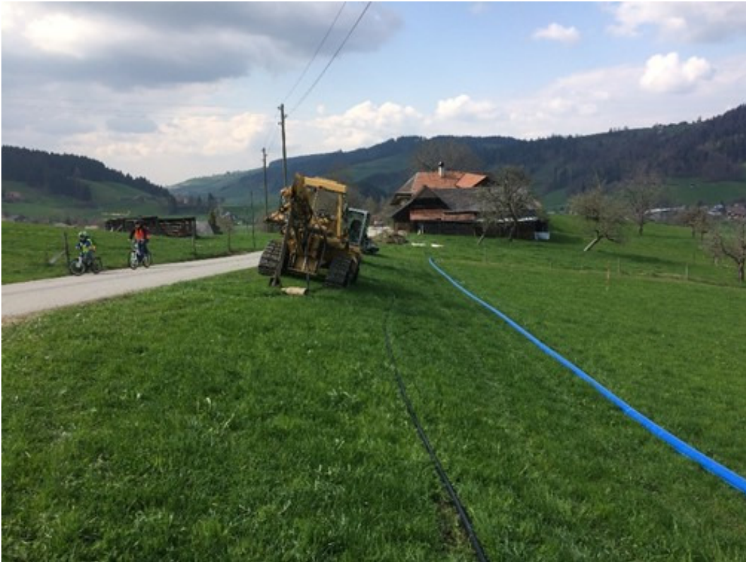
Das Gerät für das Einpfügen der Leitung steht bereit. Daneben die Leitung aus PE 160 / 130.8 mm.
