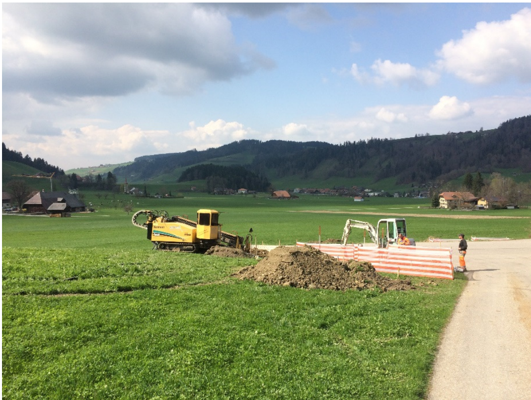
Start der Einpflügearbeiten im Moosacher, in der Nähe des Grundwasserpumpwerkes.
