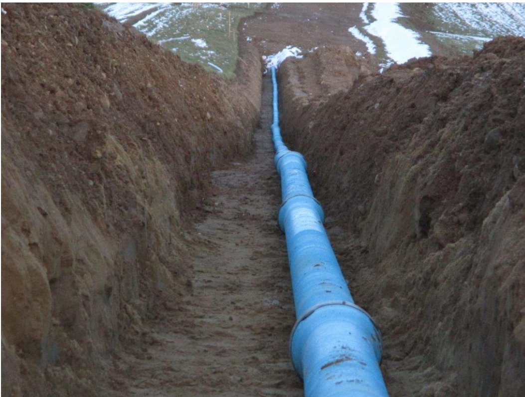
Die innen und aussen beschichtete Gussleitung, NW 150 mm, folgt der Geländeneigung.
