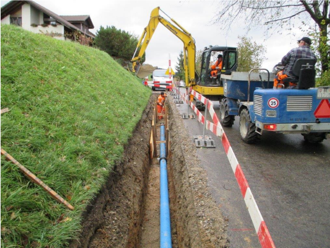
Startpunkt ist der Hydrant auf der bestehenden Leitung ausgangs Alterswil.
