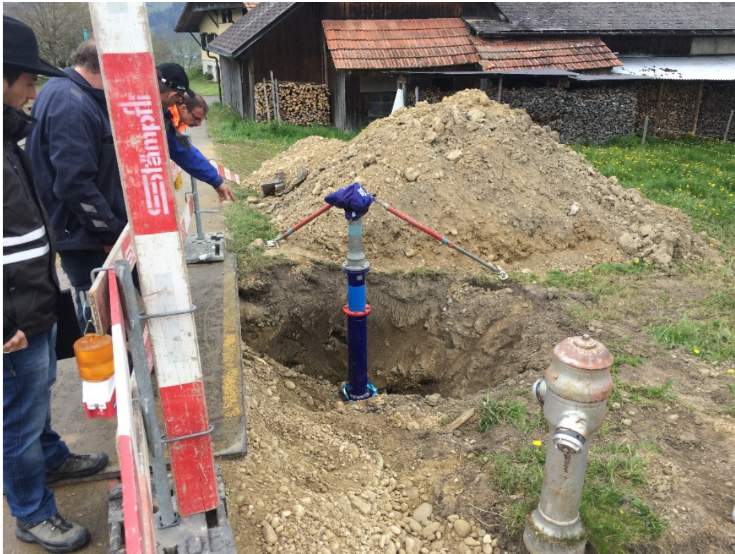
Ein alter Hydrant wird ersetzt und der neue mit einem Gestänge bis zur Eindeckung gestützt.
