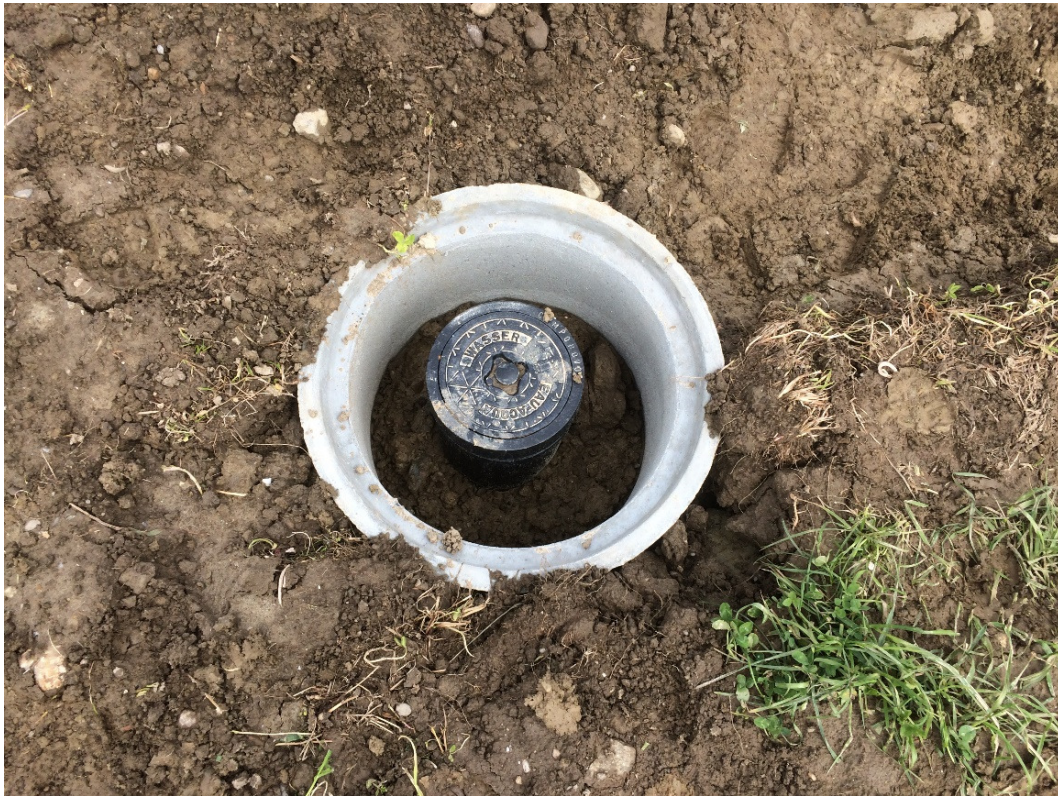
Der Schieber für den nebenstehenden Hydranten wird mit einem kleinen Schacht geschützt....
