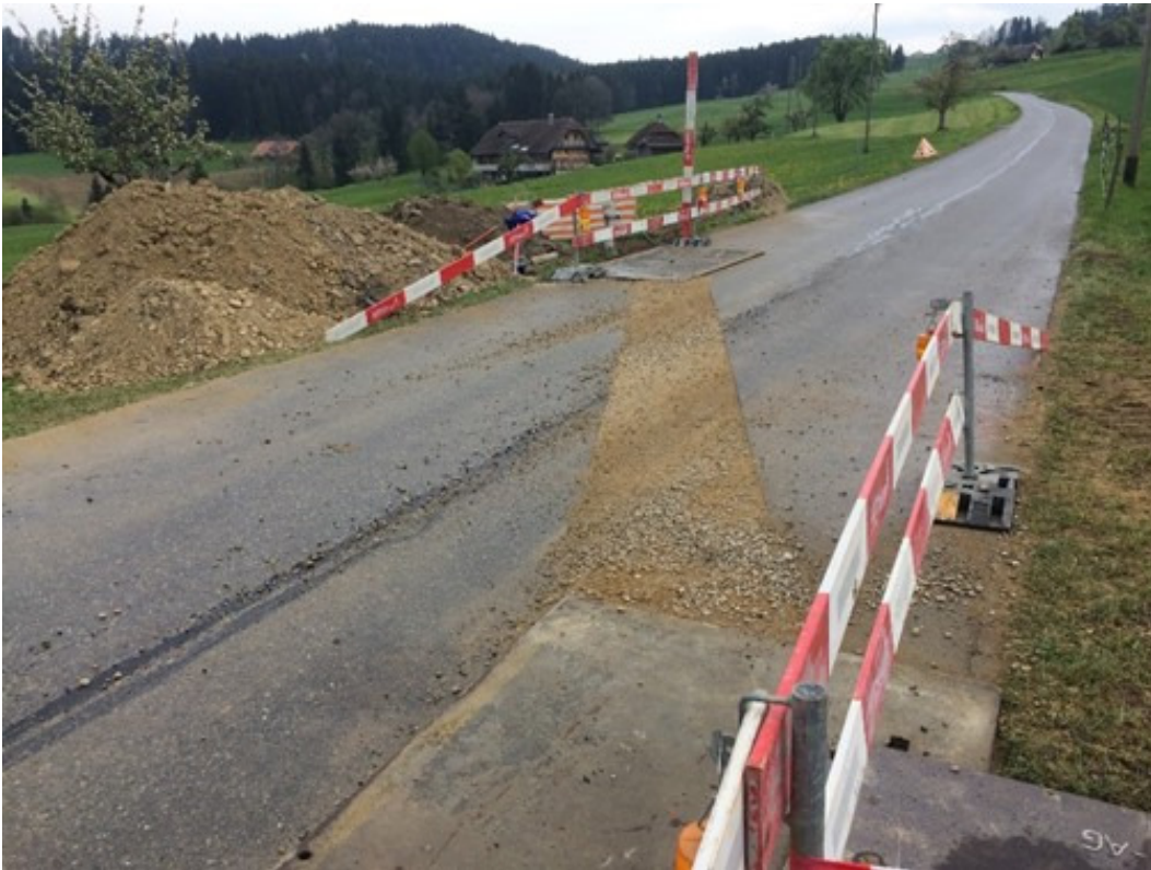
Strassenquerung unterhalb von Schwändimatt im konventionellen Verfahren (Grabarbeiten).
