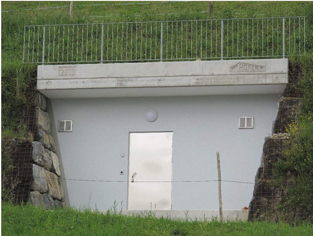
Reservoirzugang mit Gelände und seitlichen Stützmauern.
