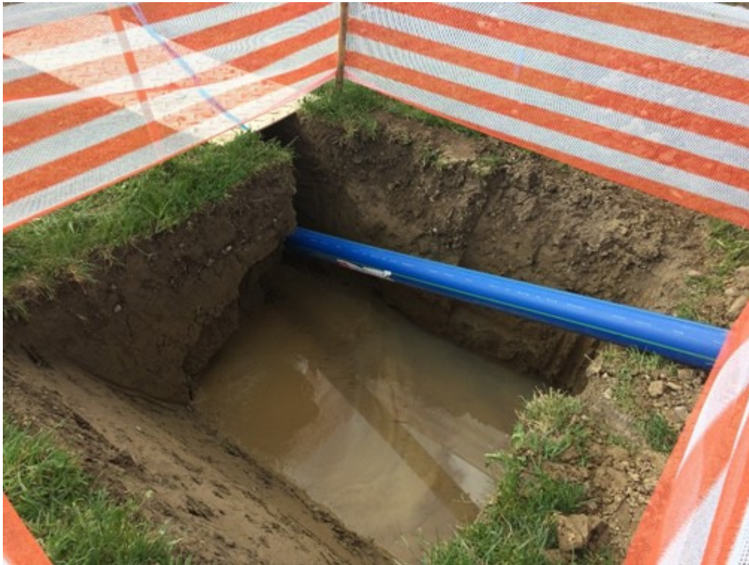
Eine Zielgrube mit der eingepflügten Wasserleitung.
