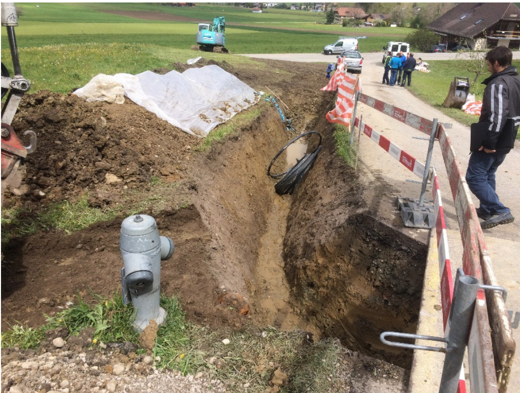
In der Breitägerten wird eine Hydrantenleitung eingelegt.
