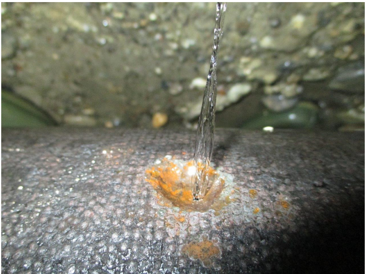
Leck in einer Graugussleitung (NW 200) von 1982 (Bahnhofunterführung, Konolfingen)
