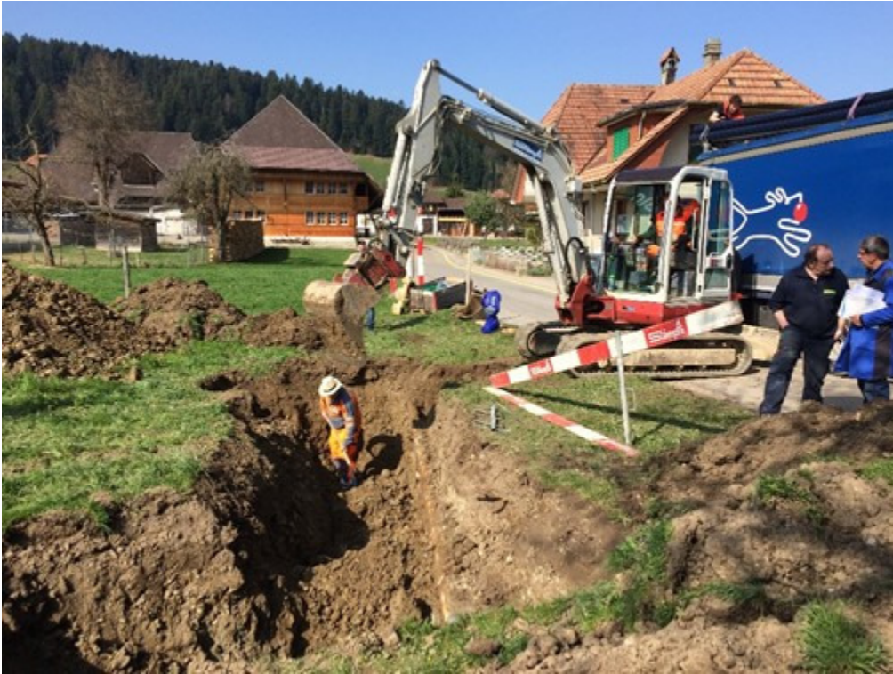
In Bowil-Dorf wird die Anschlussleitung (Reservoirableitung Schwändimatt) freigelegt.
