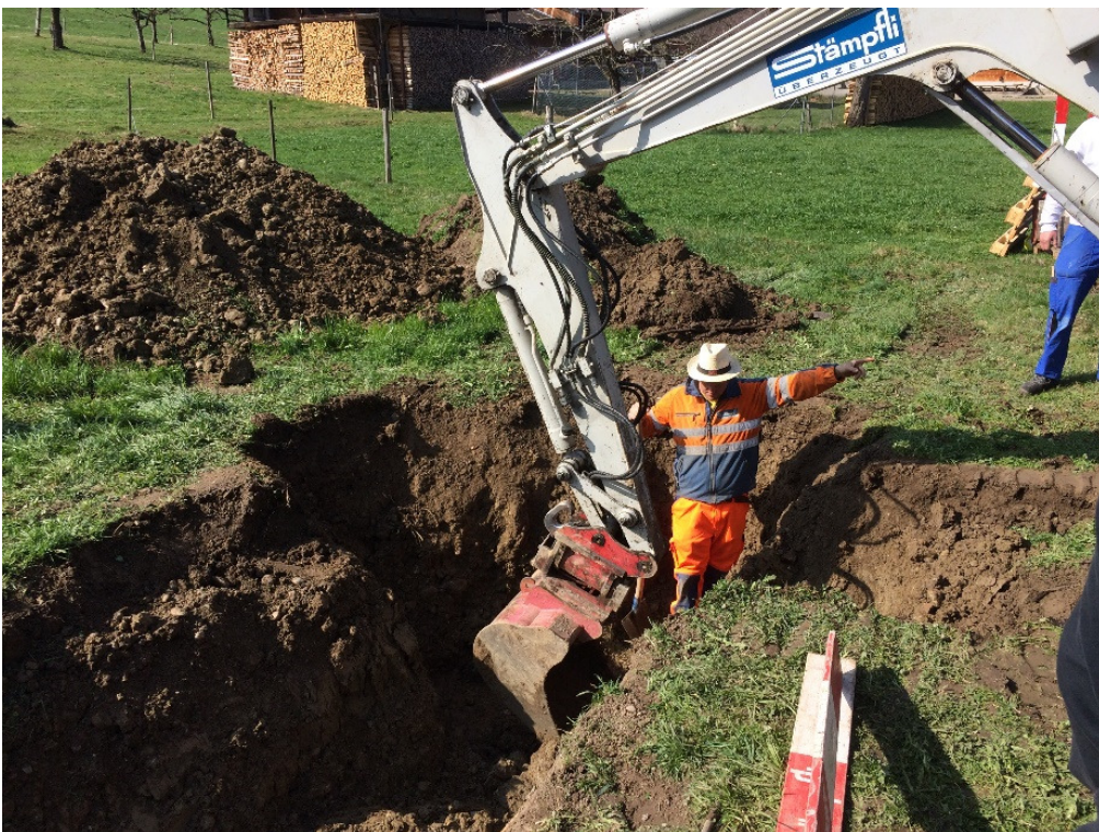
Die Leitungsfreilegung ist eine knifflige Arbeit.
