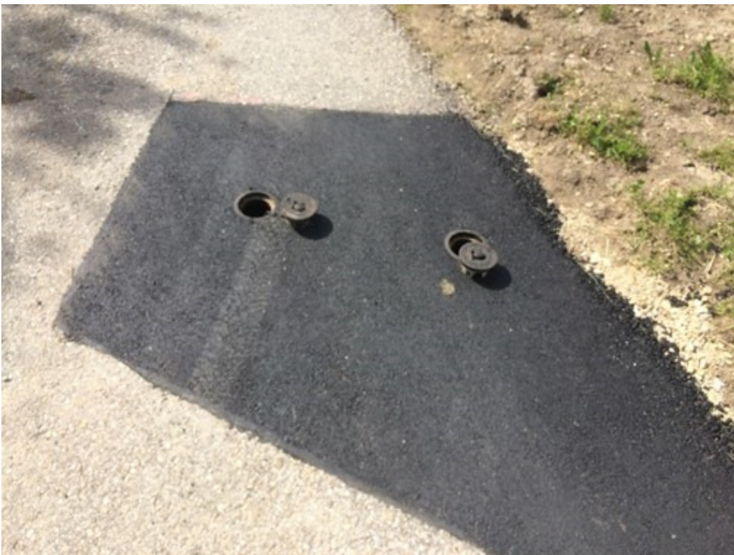
Dieselbe Stelle mit den beiden Schieberschächten in der Gemeindestrasse.
