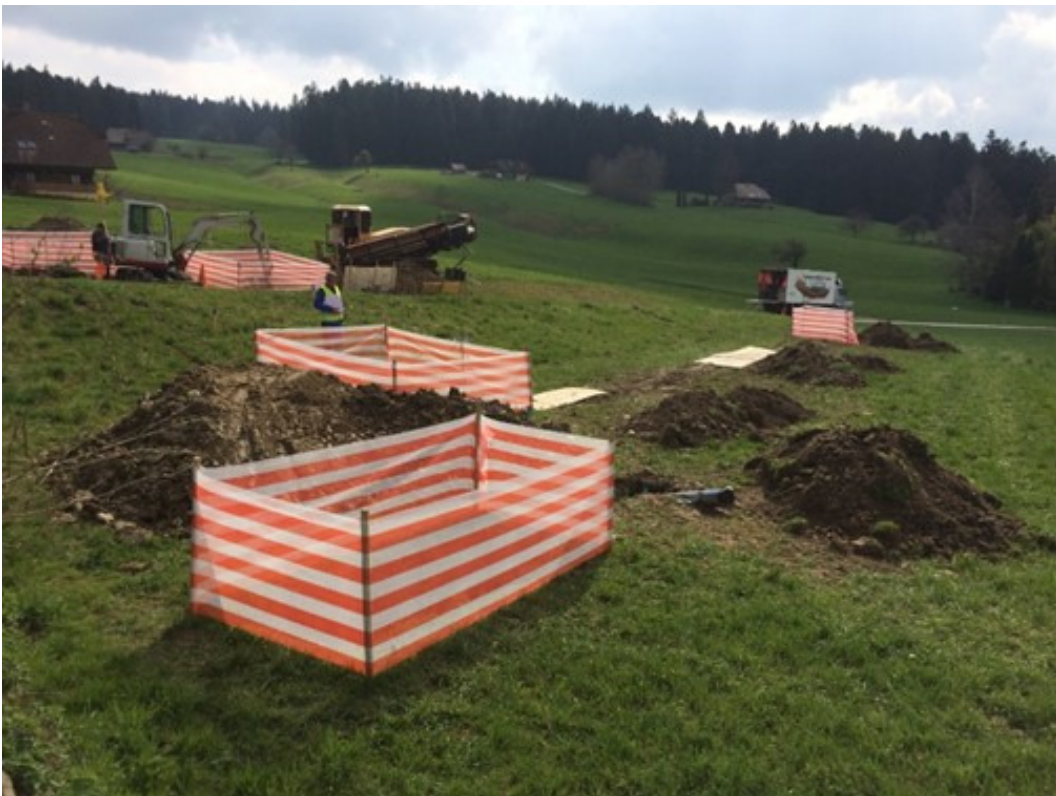
Zu Beginn und am Ende des Einpfügens sind jeweils Gruben für den Leitungsanschluss erforderlich.
