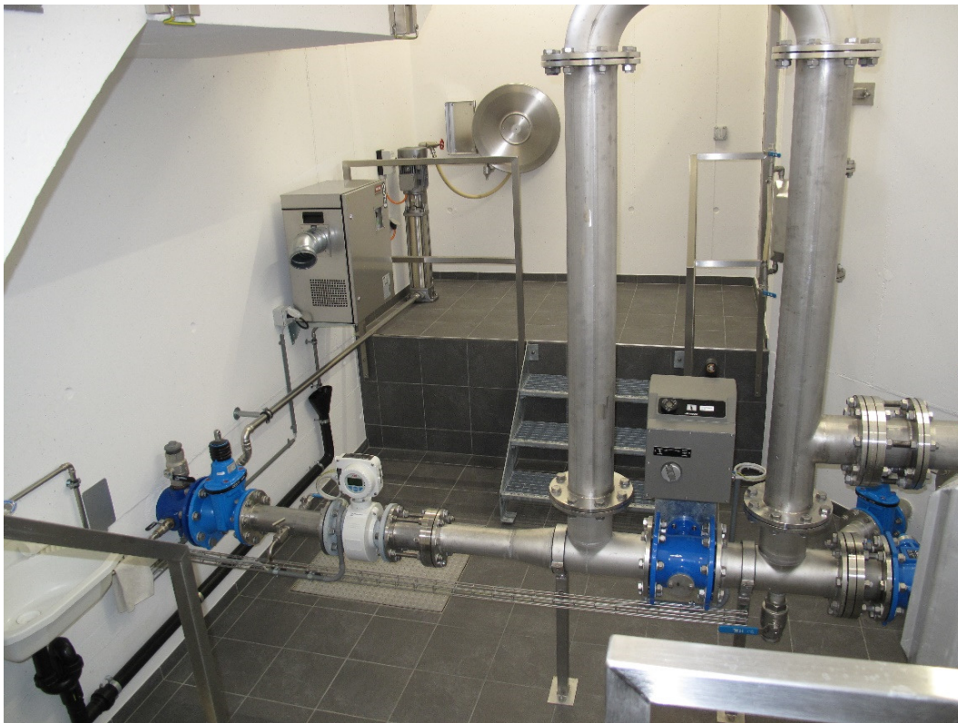
Rohrkeller im Reservoir Chrutberg, Oberthal mit Löschbogen und diversen Messeinrichtungen.
